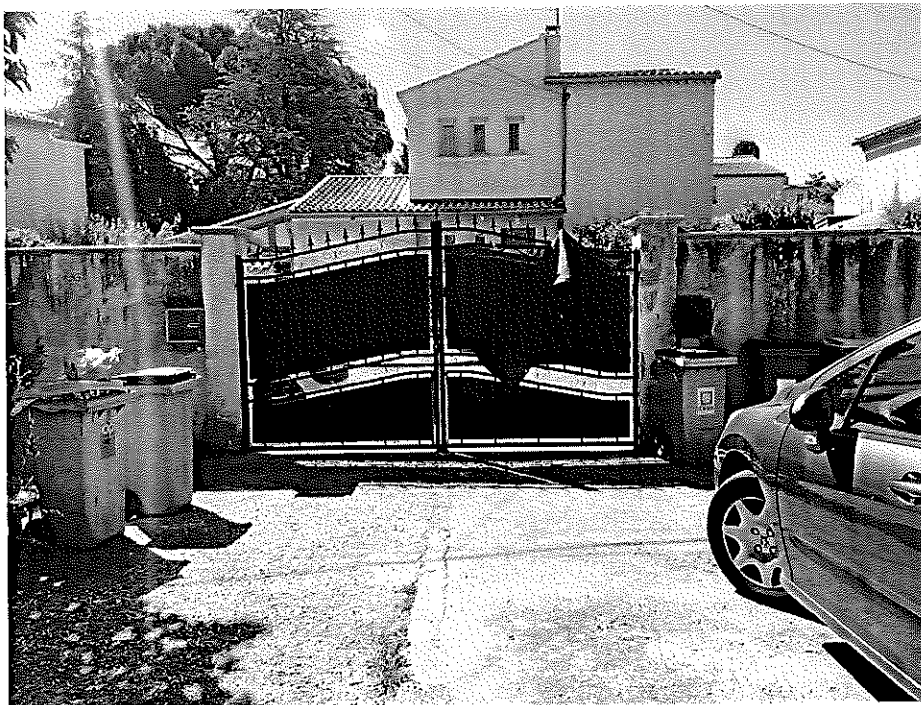
2. Portail s'ouvrant sur la rue du Temple.
