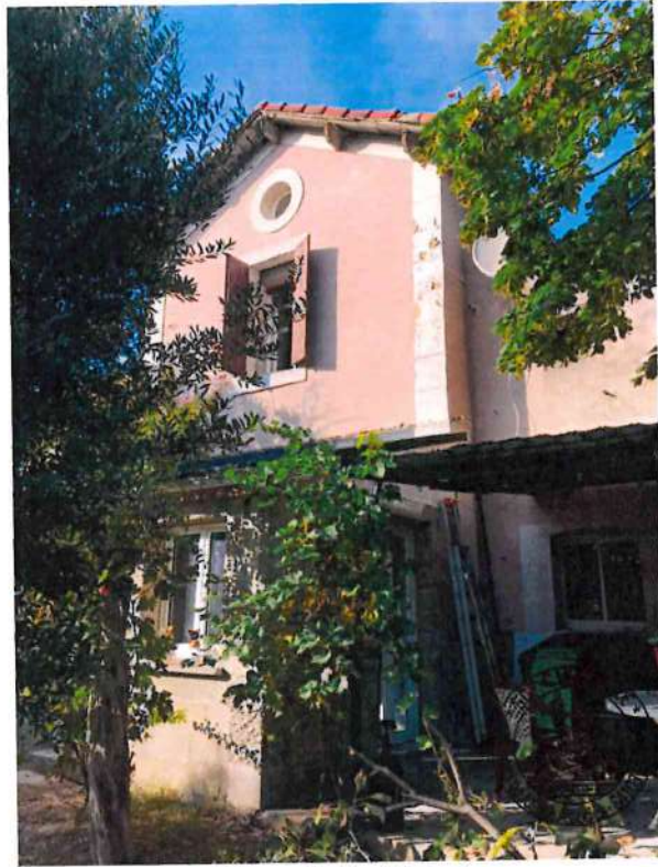
9 Façade Sud Ouest
