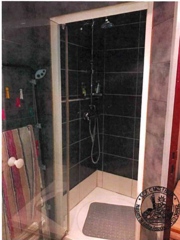
3. Cabine de douche
