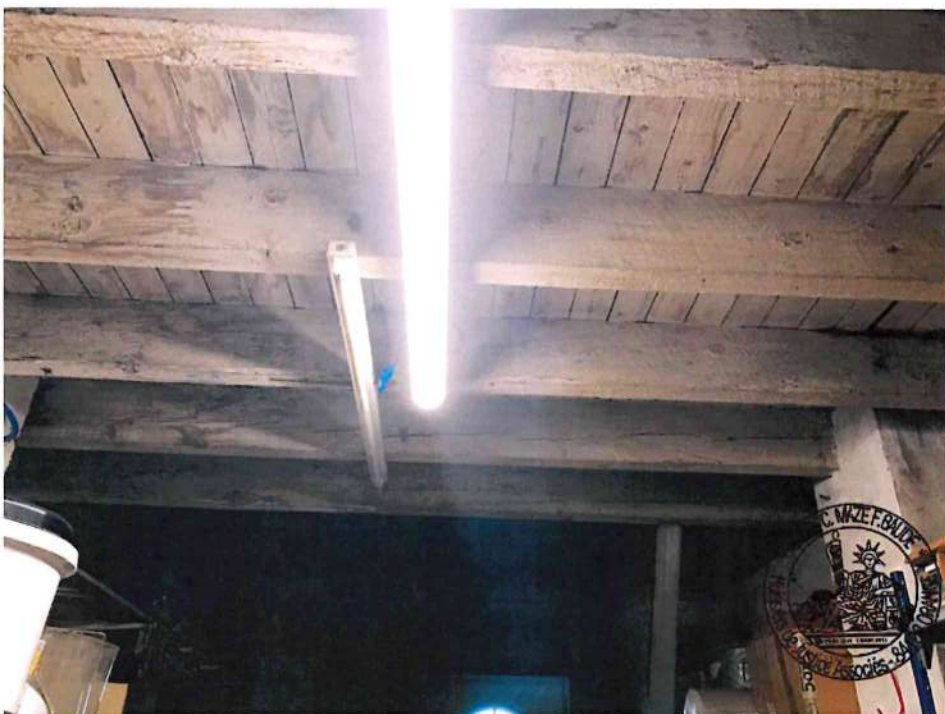
6. Plafond en bois et poutre
