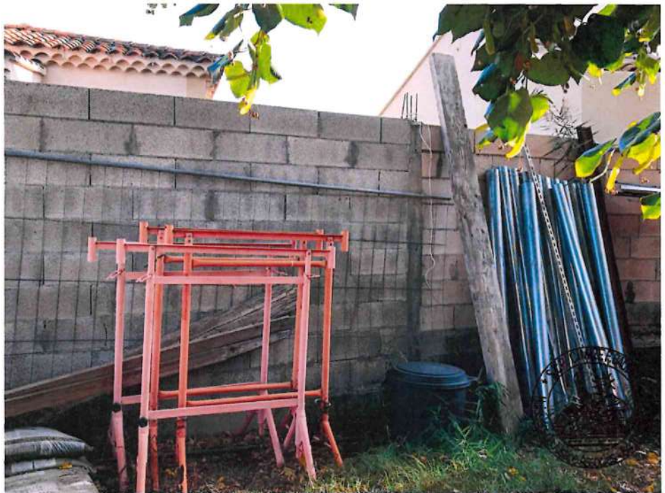
6 Mur de clôture Sud
