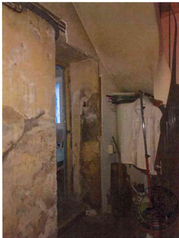
1. Passage accès salle de séjour et montée d'escaliers
